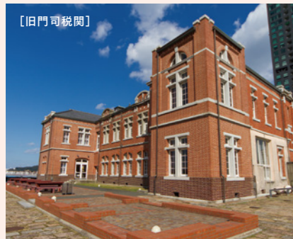
煉瓦造瓦葺2階建構造のモダンな建物です。2階には展望室があり、関門海峡や門司港レトロを一望できます
