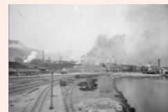
1912(明治45)年当時の製鐵所と旧本事務所の様子
