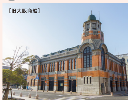
1917(大正6)年に建てた大阪商船門司支店を修復。1階は「わたせせいぞうギャラリー」となっています
