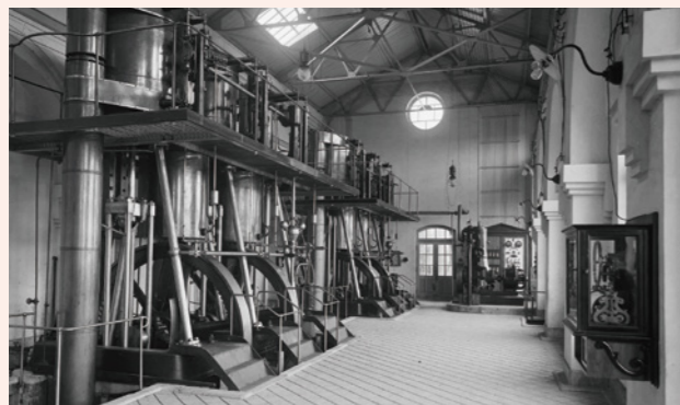
操業当時の遠賀川水源地ポンプ室の蒸気ポンプ
