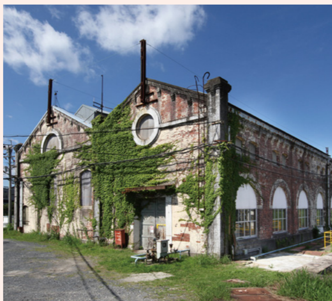
遠賀川水源地ポンプ室外観(非公開施設)
